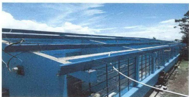
Foto. 3 Mantenimiento a Estructura de soporte de metal
