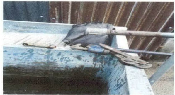
Foto 4. Sustitución de grifo
