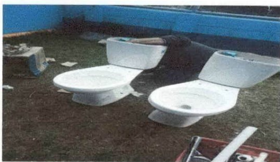
Foto 5. Sustrucción de accesorios de inodoro
