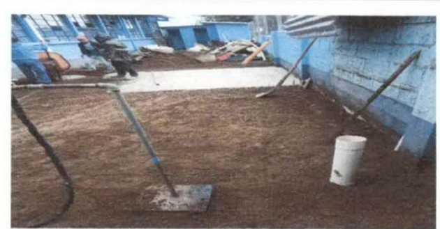
Foto 6. Reparación de piso de torta de concreto
