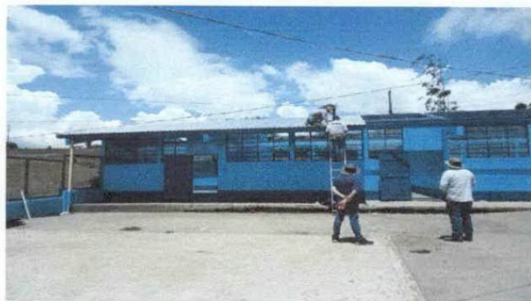
Foto 1 Sustrucción de lámina troquelada aluzinc calibre 26
