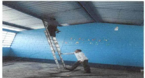
Foto 2. Reparación de sistema eléctrica
