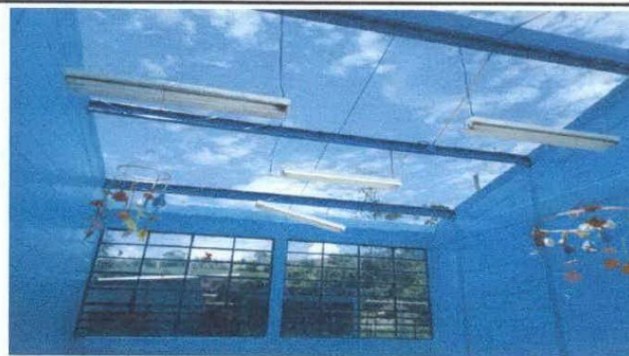
Foto 4. Mantenimiento a estructura de soporte de metal
