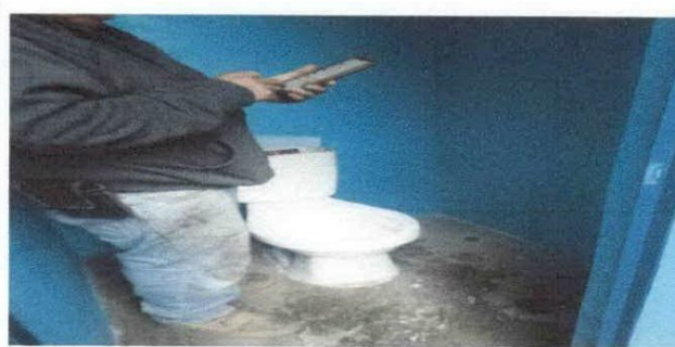
Foto 6. Sustrucción de inodoro
